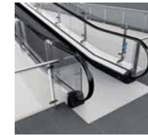
Valbeveiliging tot 1300 mm hoogte. Aanbevolen indien een val van meer dan 6 meter mogelijk is.
