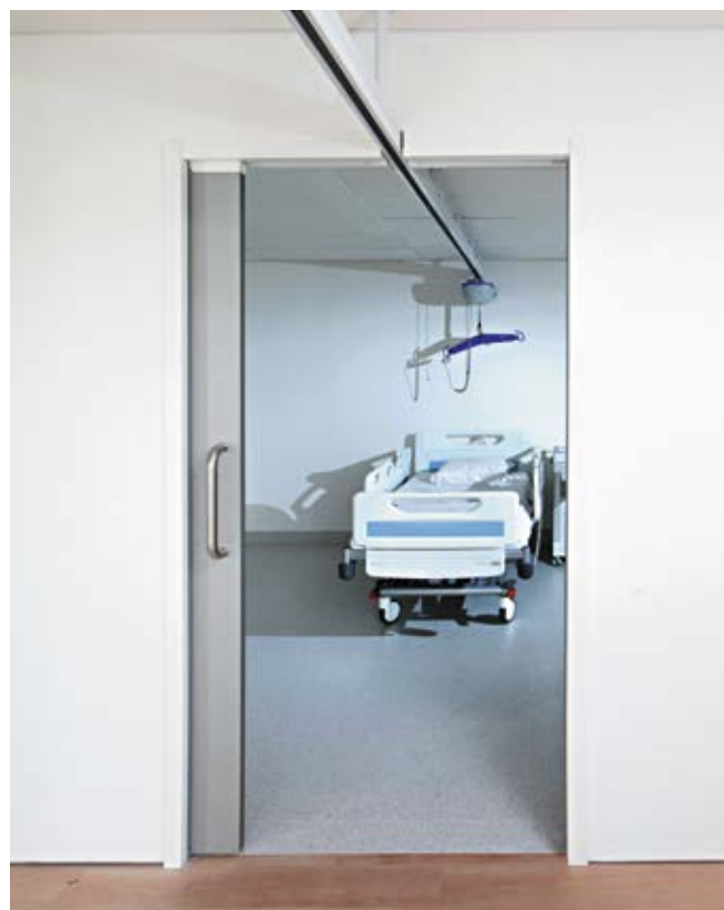
Handbediende zweefdeur als onderbroken systeem geïntegreerd met een patiënten tillift systeem
