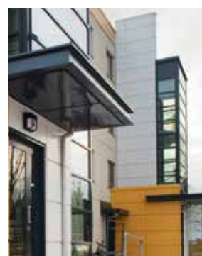
Lift naast het trappenhuis
