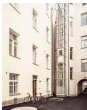
Lift buiten het gebouw in een externe schacht
